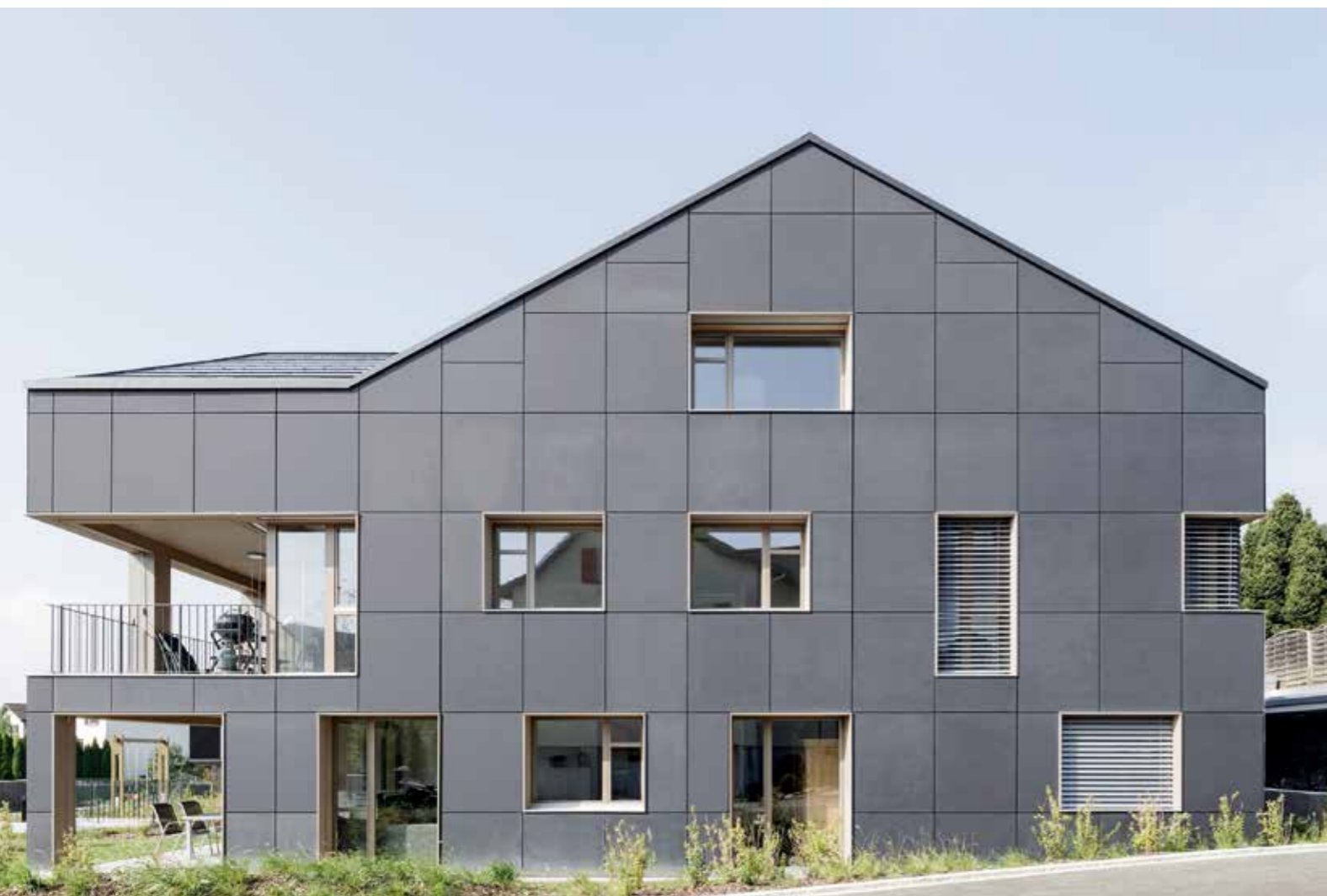
Erstes energieautarkes Mehrfamilienhaus der Welt - ein Projekt der Umwelt Arena Schweiz und smartwindows.
